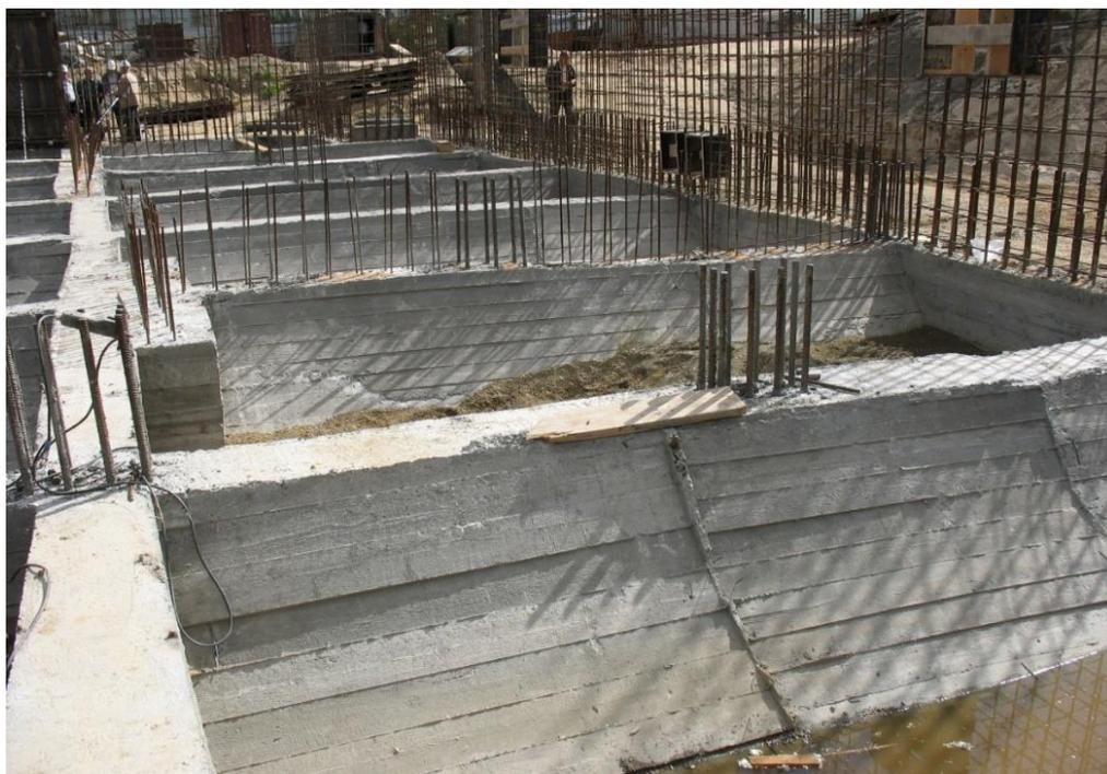
*Рисунок 7 – Процесс устройства плитно-свайного фундамента арочного типа. Этап бетонирования конструкции.*
