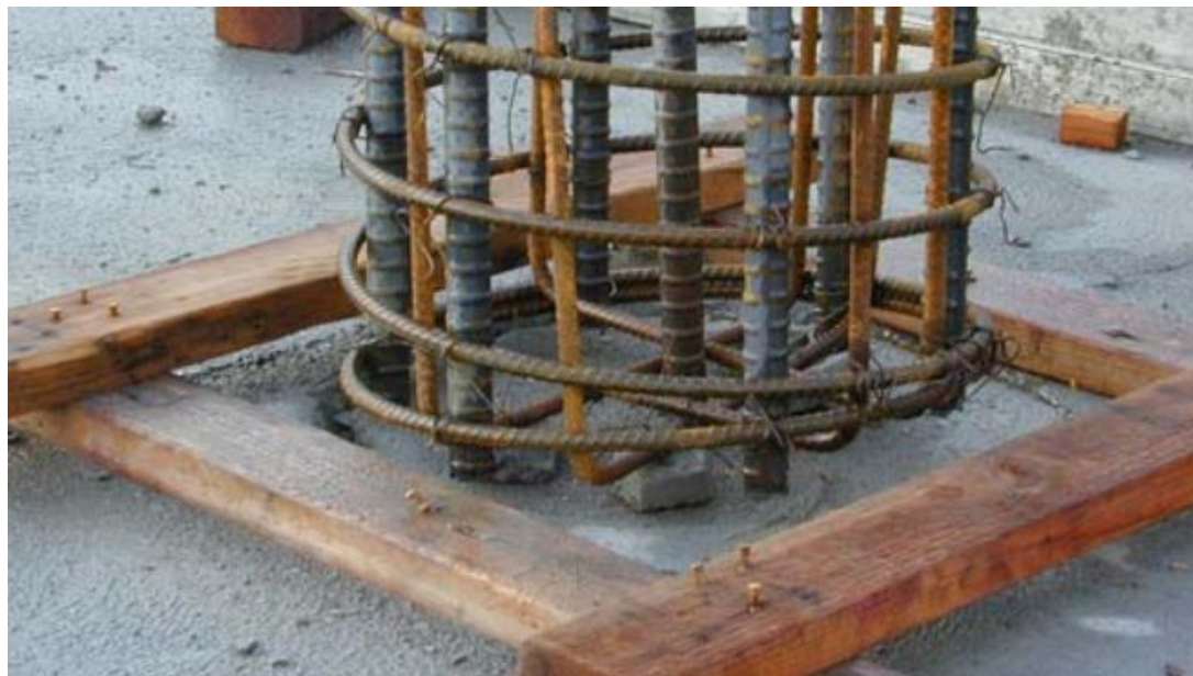
Рис.4. Шарнирный узел соединения колонны и перекрытия
