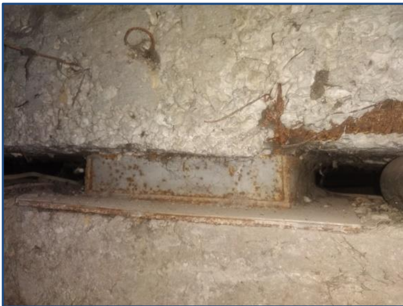
Общий вид элементов скользящих опор
