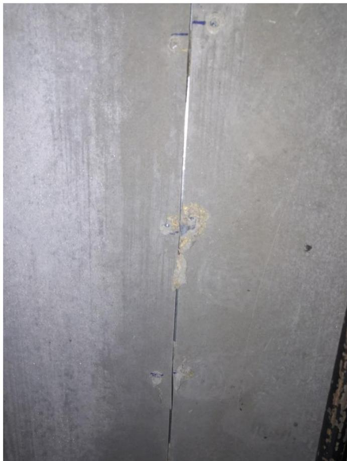
*Рис.25. Характер разрушения цементно-стружечной плиты в местах крепления к стальному каркасу при помощи самонарезающих винтов.*
