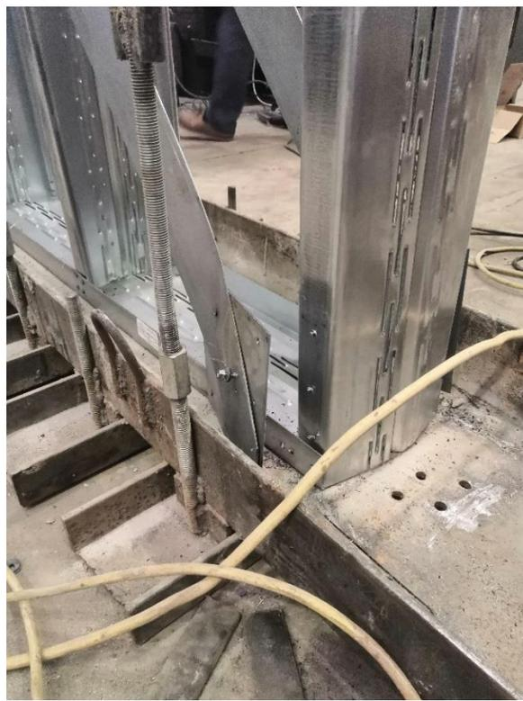
*Рис.16. Полный отказ связей (разрушение узлов соединения)*
