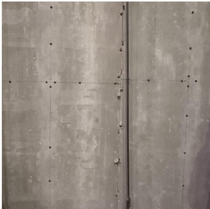
**Рис.21.** Разрушение зон крепления обшивки по краю (в зоне стыка двух плит) плиты ЦСП
