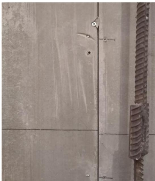
**Рис.18.** Изменение горизонтальной соосности панелей ЦСП. Скол плиты в зоне крепления
