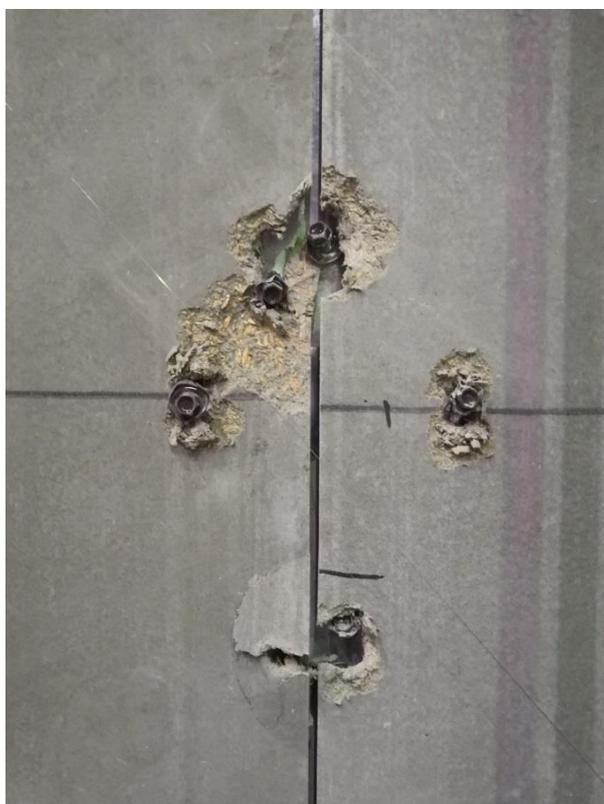
**Рис.22.** Разрушение плиты ЦСП и крепления вдоль стыка плит
