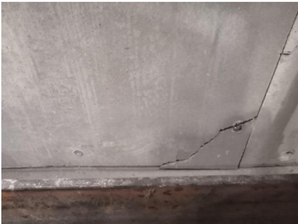
**Рис.19.** Скол угловой зоны плиты ЦСП в средней части стеновой панели (зона стыка панелей)
