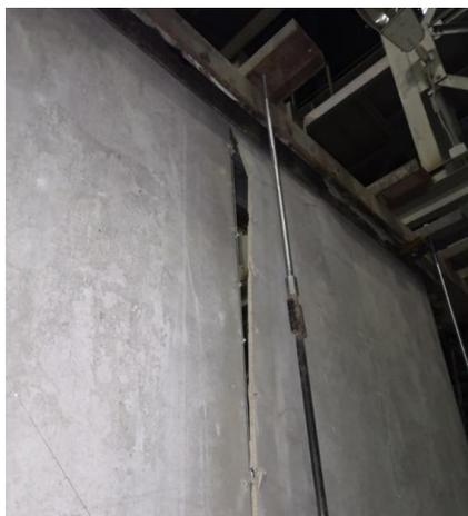
**Рис.24.** Разрушение зоны стыка соединения двух плит ЦСП
