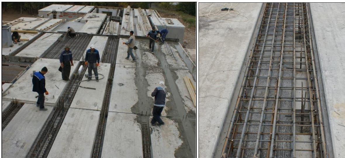
Рисунок 4 – Общие виды перекрытия крупнопанельного жилого дома в процессе устройства монолитных армированных связевых участков
