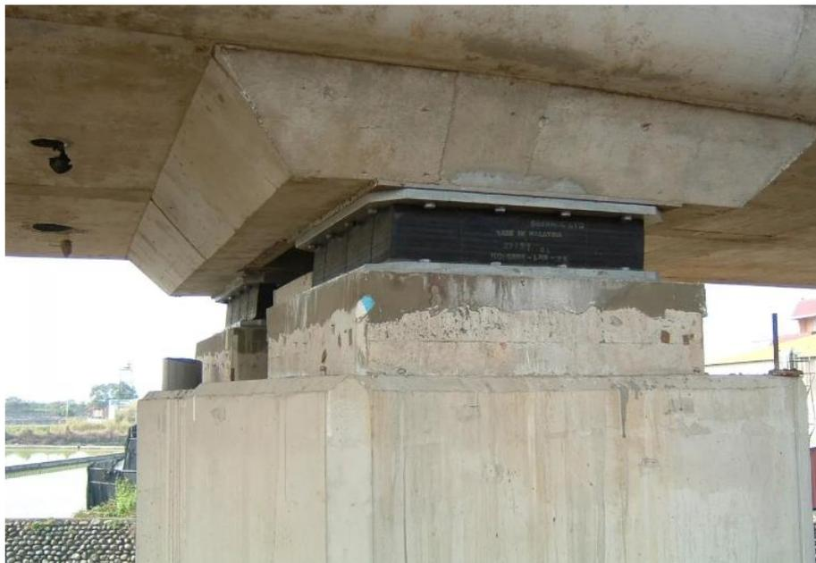
Анализ имеющихся материалов по обследованию зданий с системами сейсмоизоляции после сильных землетрясений подтверждает, что эта система является достаточно эффективной и сопровождается сохранением строительных конструкций.
