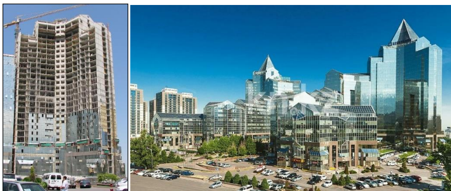
Рисунок 3 Общий вид здания до и после строительства
