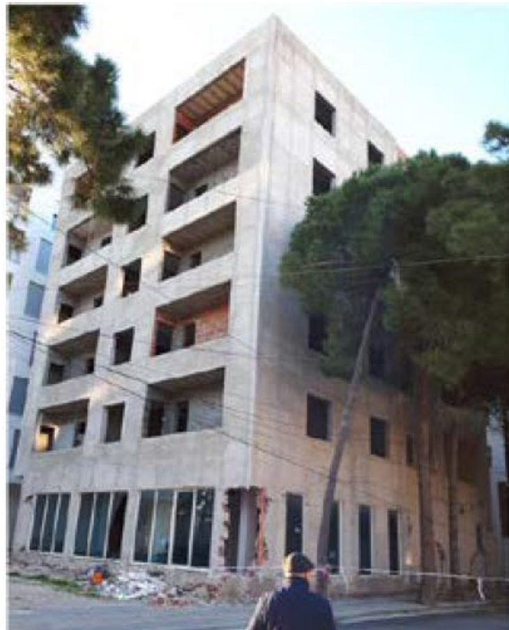
Разрушение ЖБ каркасного здания в Дуррес. Албания из-за эффекта кручения: а) вид здания после землетрясения; б) повреждение ирпичного заполнения на первом этаже (прилегающей к лестнице) в) поврежденная лестничная площадка (Nikolić-Brzev et al., 2020)
