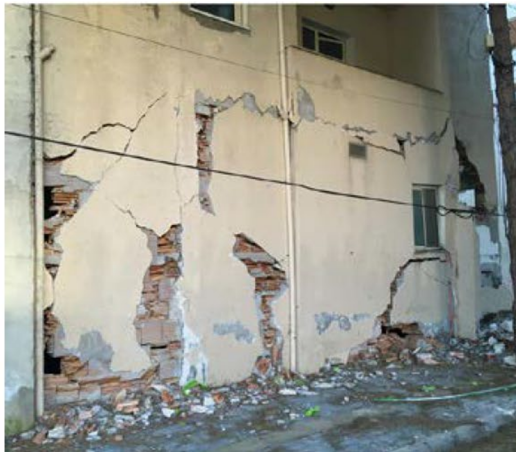
Разрушение ЖБ каркасного здания в Дуррес. Албания из-за эффекта кручения: а) вид здания после землетрясения; б) повреждение ирпичного заполнения на первом этаже (прилегающей к лестнице) в) поврежденная лестничная площадка (Nikolić-Brzev et al., 2020)
