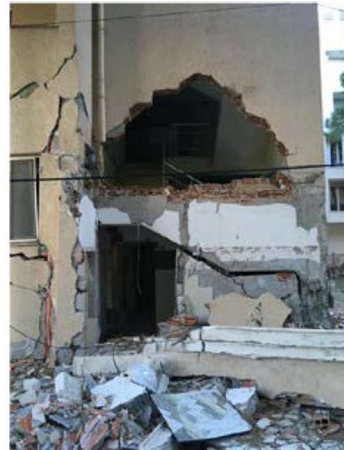
Разрушение ЖБ каркасного здания в Дуррес. Албания из-за эффекта кручения: а) вид здания после землетрясения; б) повреждение ирпичного заполнения на первом этаже (прилегающей к лестнице) в) поврежденная лестничная площадка (Nikolić-Brzev et al., 2020)
