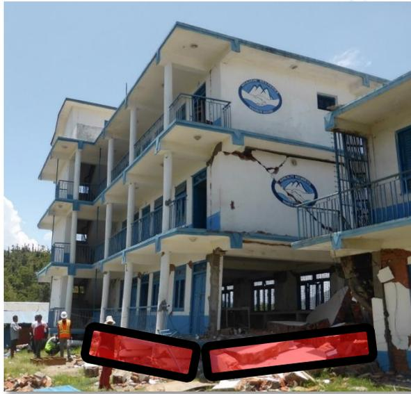
Обрушение железобетонного здания школы в Непале из-за механизма гибкого (слабого) этажа на уровне 1-го этажа
