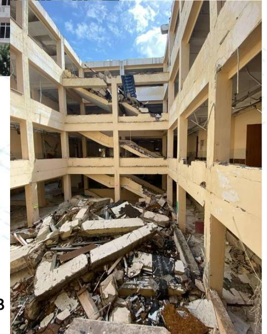
Обрушение железобетонного здания школы в Турции из-за механизма слабого (гибкого) этажа на уровне 1-го этажа (из-за землетрясений в феврале 2023 г.)
