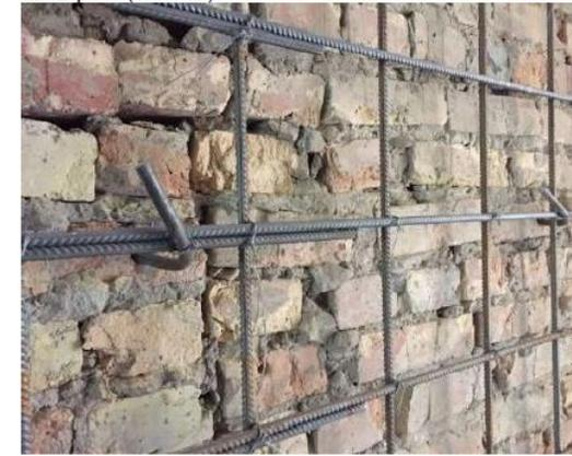
Конечное положение анкеров в стене (после армирования стены и сгибания концов анкеров)
