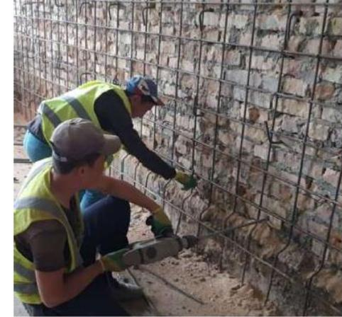
Сверление отверстий в стене для установки анкеров (Энкон)
