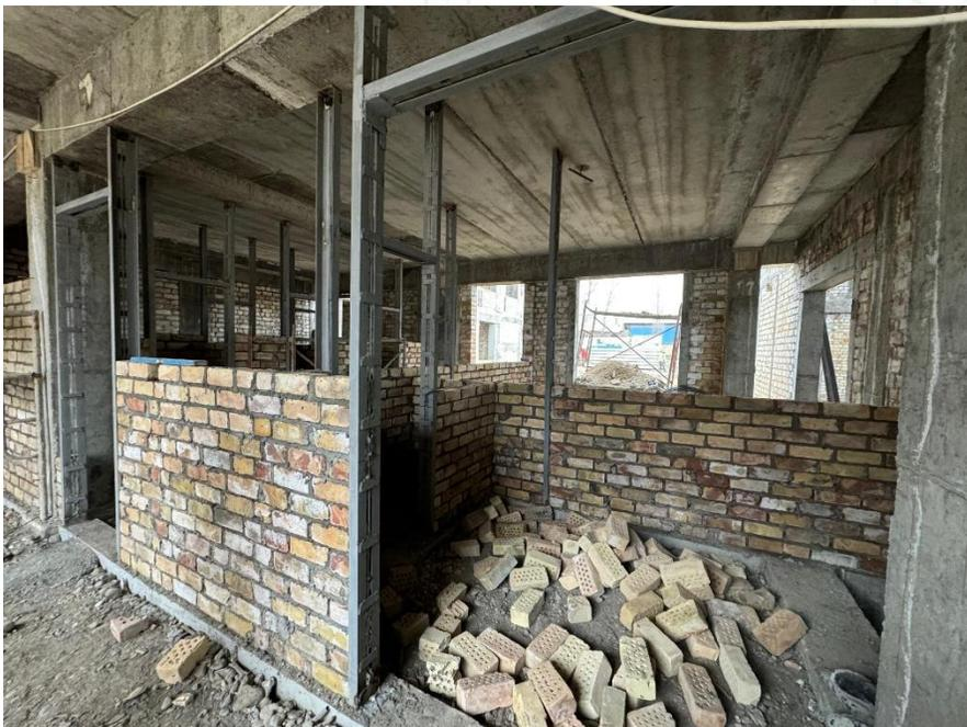
например, перегородки кирпичной кладки усилены с помощью металлических уголков **вместо жб включений**
